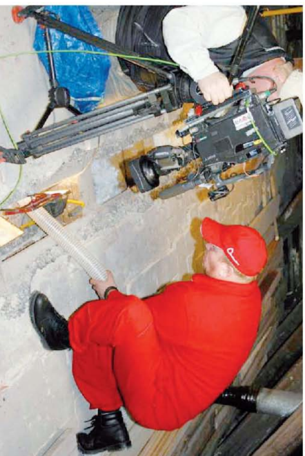
Při montáži pořadu Rady pánka loskurka - zateplení dutiny trnového stropu
